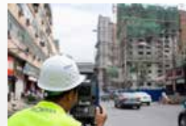
施工竣工测量
